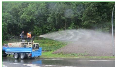
Bei der Anspritzbegrünung im Nassansaftverfahren werden in einem speziellen Rürtank (Hydroseeder) sowohl das für den jeweiligen Standort optimale Saatgut, als auch Mulchfasern, Düngemittel, Bodenkleber und weitere Bodenverbesserungsstoffe gemischt und über eine druckstarke Sprühlanze direkt auf die zu begrünende Fläche gespritzt. Alle Stoffe sind selbstverständlich biologisch unbedenklich.
